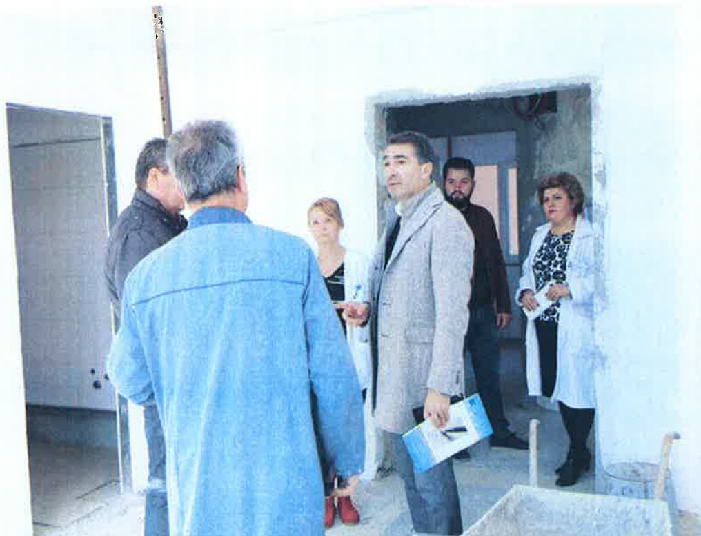
9 martie 2018, vizită verificare stadiu lucrări reabilitare Secție Pediatrie din Spitalul Județean de Urgență Piatra-Neamț
