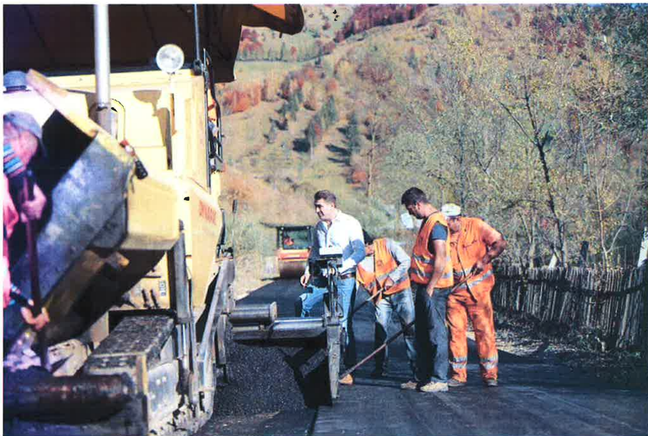
17 octombrie 2017, verificare stadiu lucrări pe drumul județean DJ 127 A, pe raza comunei Bicazu Ardelean
