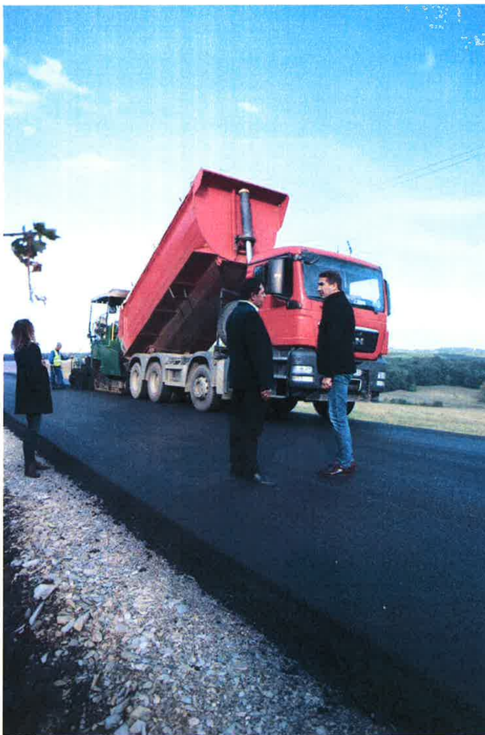
26 septembrie 2017, verificare stadiu lucrări la drumul județean 155 B, ce leagă Bodeștiul de comuna Petricani
