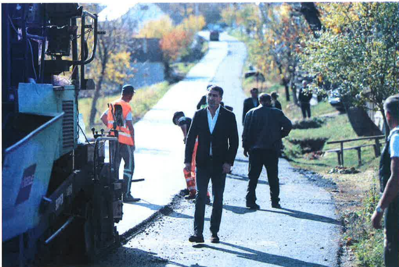
18 octombrie 2017, lucrări de modernizare a drumului județean DJ 155 L, tronsonul dintre comunele Ghindăoani și Grumăzești
