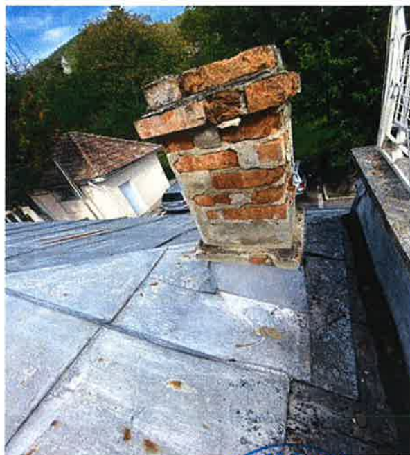
Degradariile invelitorii de tip beton amprentat din zona terasei necirculabile corp C1
