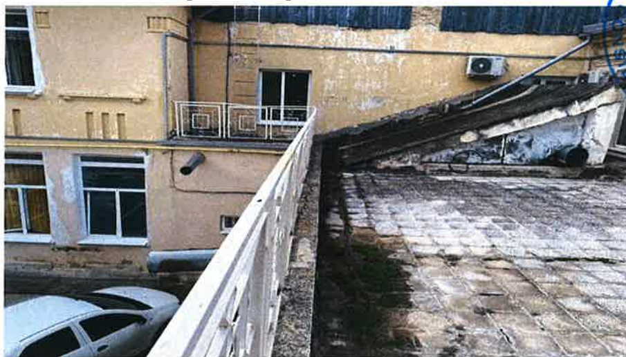
Degradariile invelitorii de tip beton amprentat din zona terasei necirculabile corp C1
