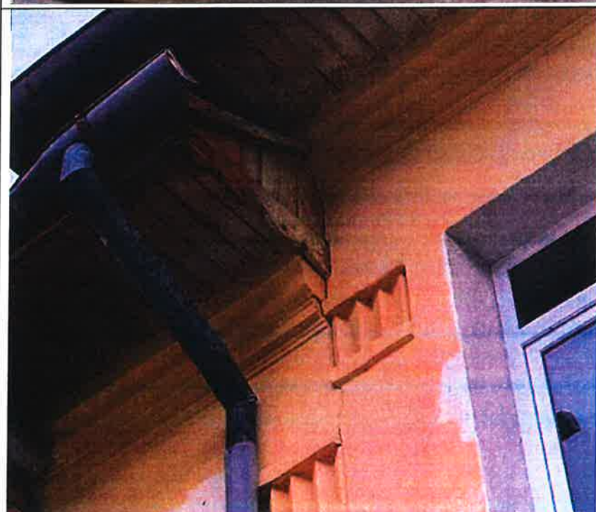
Fig. 2.f. Fisura pereti.
