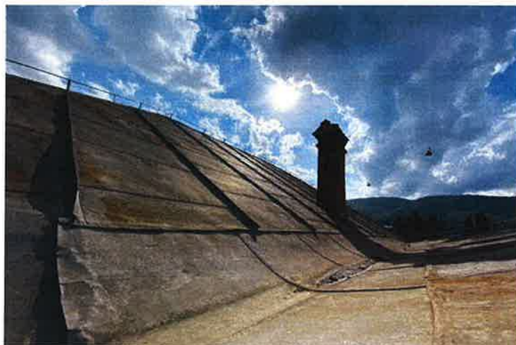
Degradariile invelitorii de tip beton amprentat din zona terasei necirculabile corp C1
