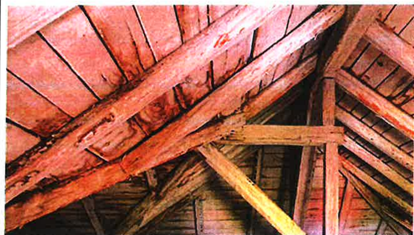
Fig. 2.c. Elemente degradate, umede, putrezite și dislocate din cauza infiltrațiilor de apă.
