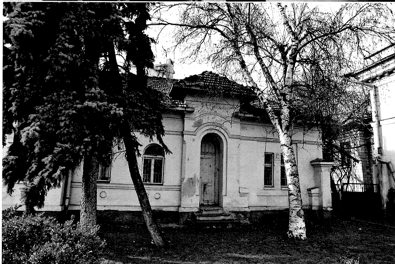
Vizitarea clădirii istorice din centrul oraşului Chişinău, care urmează să fie reabilitată şi transformată în Centrul Cultural „Eugen Doga”
