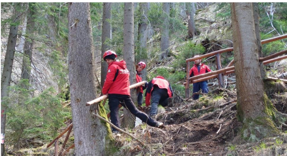
Montare de balustrade de protecție
