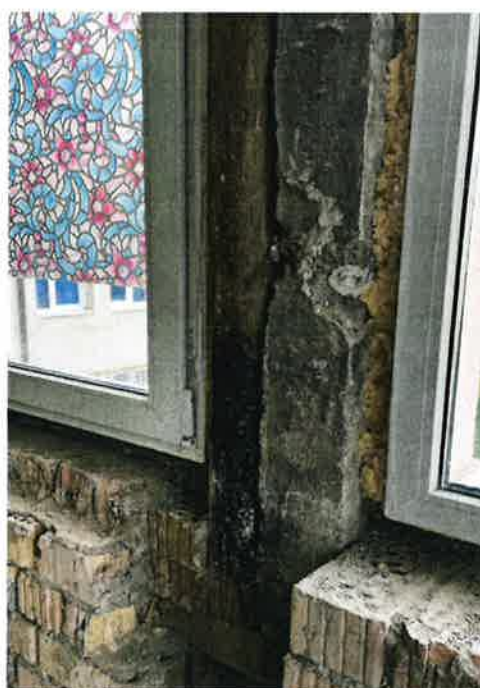
Foto 5.2 și foto 5.3- Parapeți ferestre - conformare și pozitionare elemente prefabricate din beton
