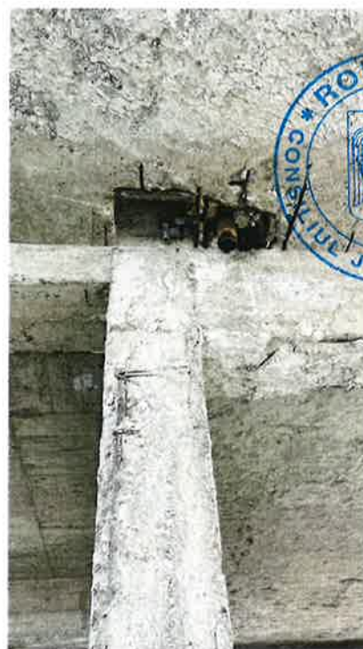
Foto 5.8- Goluri neconforme în plăci și armături vizibile
