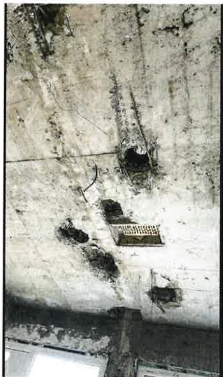
Foto 5.8- Goluri neconforme în plăci și armături vizibile
