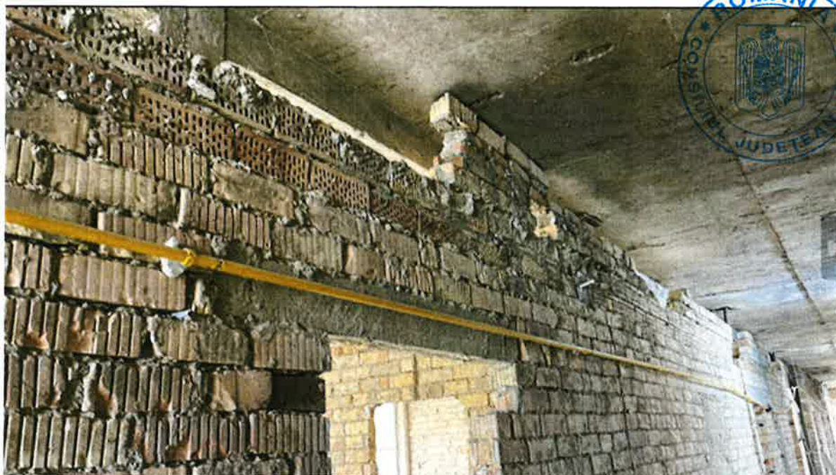
Foto 5.1- Pereții de compartimentare hol - conformare și poziție
