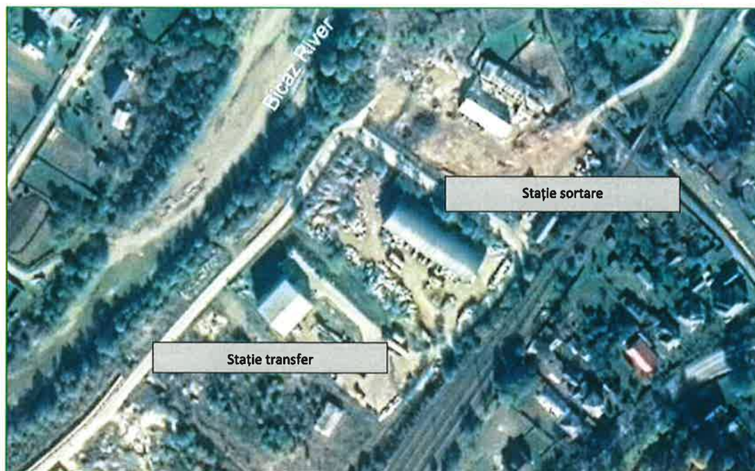
Figura 4-1 Stație transfer și stație sortare Tașca (Google Earth)
